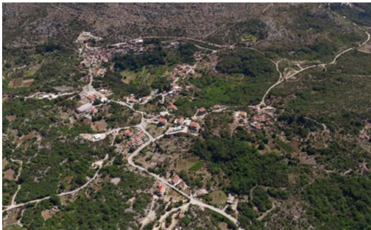
Slika 5-1 Kompleksan sustav dolaca kao osnova organizacije ruralne cjeline Gromače, ali uz vidljive suvremene negativne prostorne promjene u vidu nove izgradnje i širenja građevinskog područja
