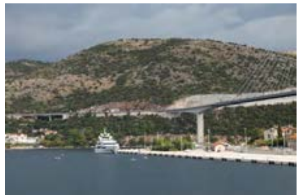
Slika 19-10 Prometna infrastruktura na ulazu u Grad Dubrovnik
