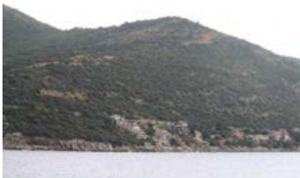
| Slika 19-5 Nizovi apartmanskih objekata
